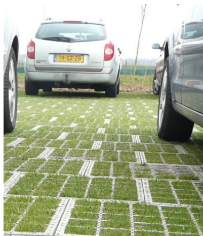
Les dalles engazonnées donnent l'assurance d'un revêtement stable, propre à supporter le poids des véhicules, sans altérer la perméabilité du sol.
