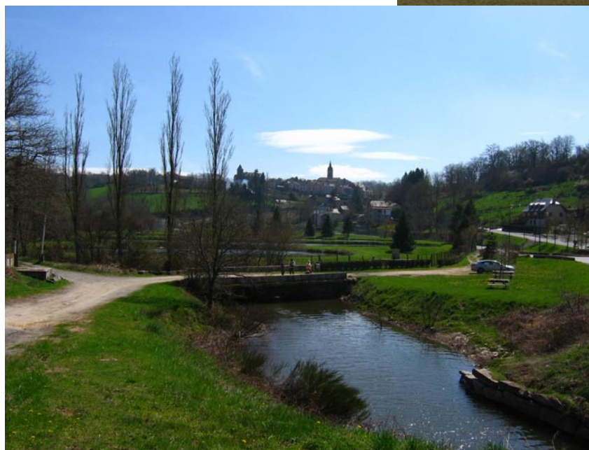
Secteur en zone inondable
