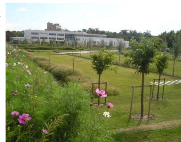
A droite, le Parking "vert" est recouvert de gazon fibré, et sert de bassin de rétention (Parc de la plage bleu - Val de Marne).
