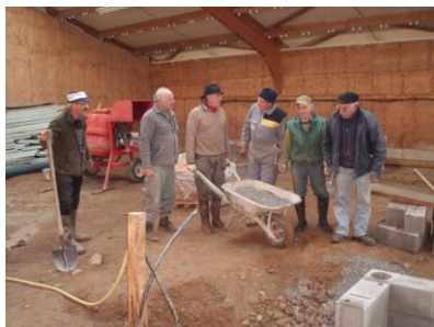
Le début du chantier
